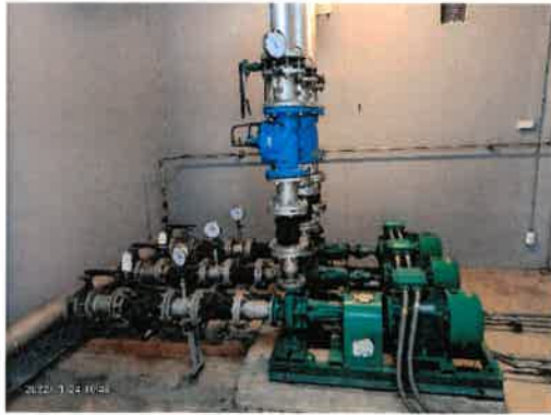
ปั๊มสูบน้ำขึ้นไปเก็บบนถังเก็บน้ำชั้นหลังคา
