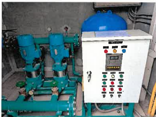
บูสเตอร์ปั๊ม เพื่อจ่ายน้ำไปยังส่วนต่างๆ ของอาคาร
