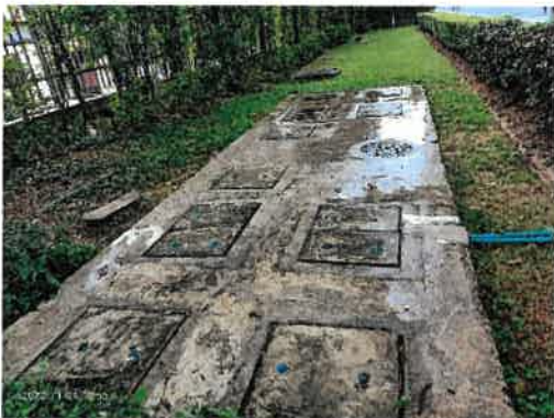
ลักษณะบ่อรวบรวมน้ำของแต่ละอาคารก่อนสูบลำไปยัง ระบบบำบัดน้ำเสีย
