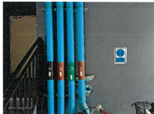
ท่อระบายน้ำฝนจากจากบนอาคาร
