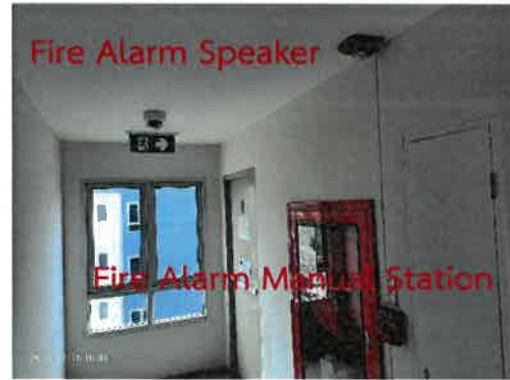
Fire Alarm Speaker และ Manual Station
