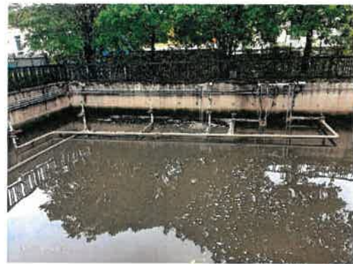
บ่อพักน้ำด้านหน้าโครงการมีการติดเครื่องเติมอากาศ
