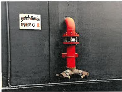
ท่อรับน้ำดับเพลิง ประจำอาคาร C
