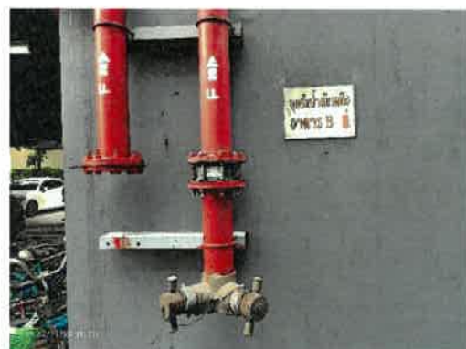
ท่อรับน้ำดับเพลิง ประจำอาคาร B
