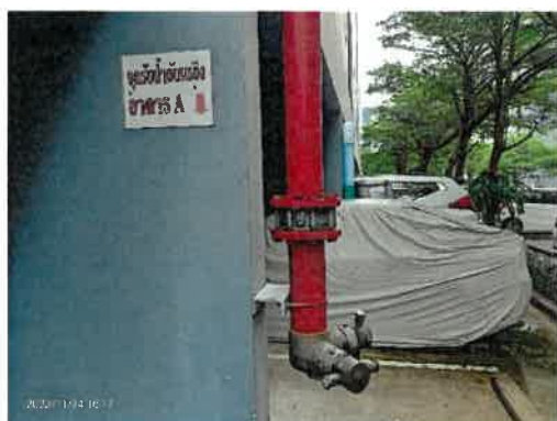
ท่อรับน้ำดับเพลิง ประจำอาคาร A
